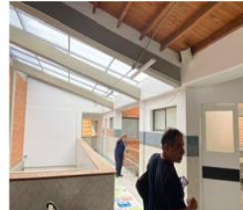
Cubiertas y muros internos - después
