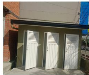
Cuarto de residuos - después
