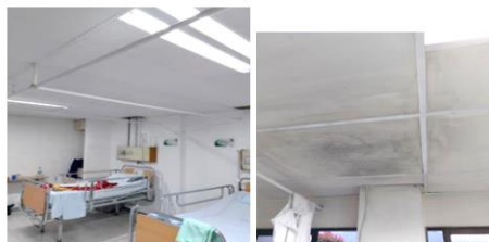
Cielos falsos habitaciones hospitalización - antes
