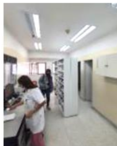
Cambio de luminarias - antes
