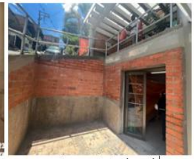
Acceso piso 1 - después
