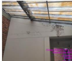
Cubiertas y muros internos - antes
