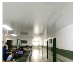
Cielos falsos hospitalización - Después
