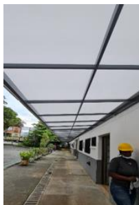
Cubierta externa - Después
