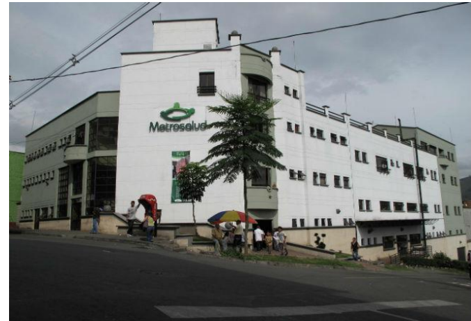
UH San Antonio de Prado Servicio de urgencias
